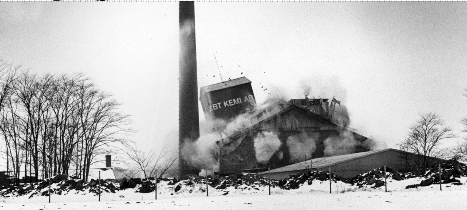
BT Kemi i Teckomatorp. Fabriksbyggnaderna sprängs i februari 1979.
